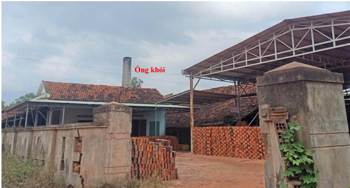
Hình 11. Hình ảnh hệ thống xử lý khí thải lò nung
