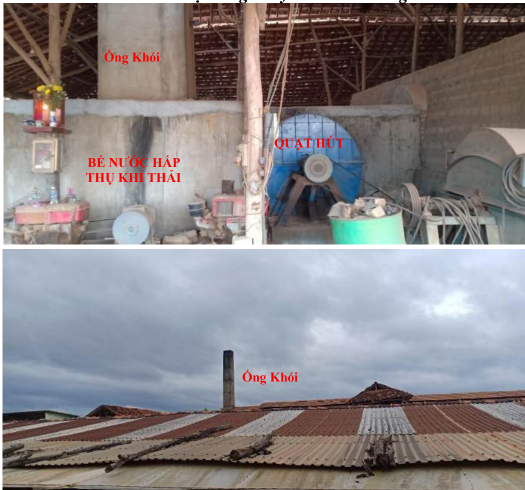
Hình 10. Hình ảnh hệ thống xử lý khí thải lò nung
