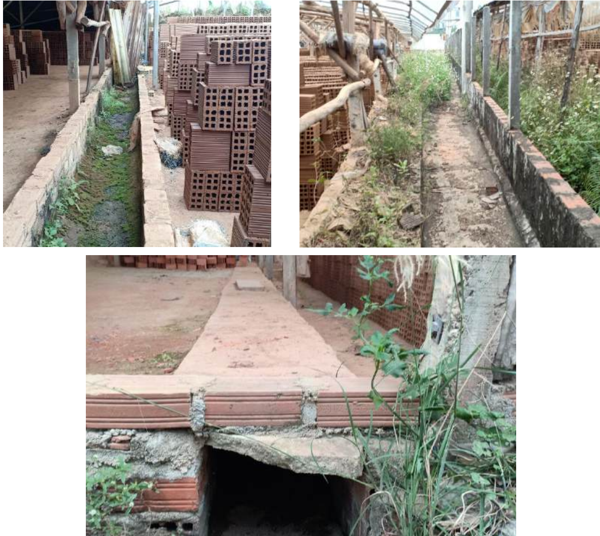
Hình 5. Các tuyến mương thoát nước mưa của nhà máy
