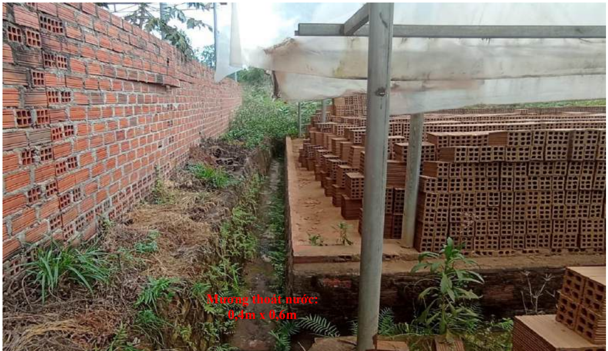
Hình 5. Các tuyến mương thoát nước mưa của nhà máy
